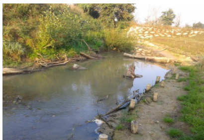
Vue de la zone amont de la station
