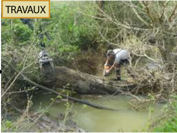
Suppression de la partie "hors d'eau" de l'embâcle
