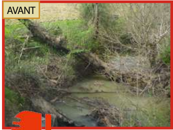
Obstruction de la section d'écoulement
