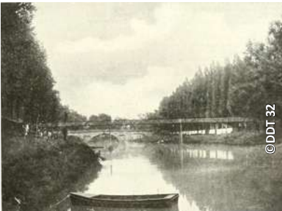
La ripisylve multiservice : bois de chauffage, bois d'œuvre, ...
