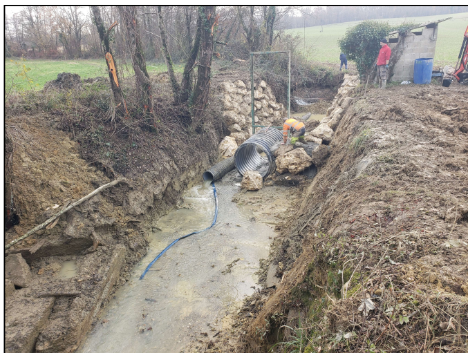
Pose du tuyau D1200 et reconstitution du seuil en blocs
