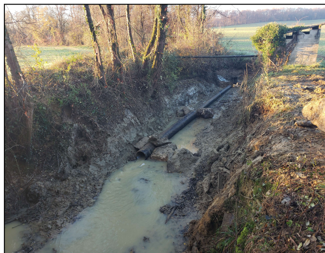
Destruction de l'ancien ouvrage et pose du batardeau
