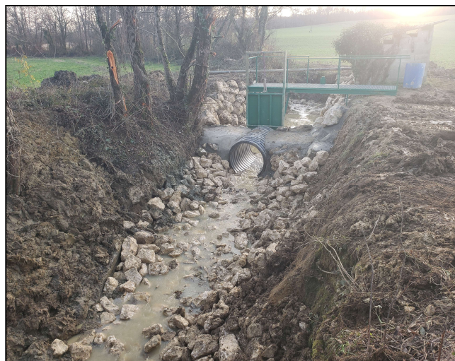
Liaisonnage des blocs du seuil et pose du radier anti-affouillement
