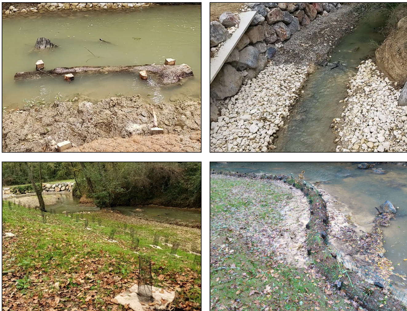
Restauration de la Douze : fixation d'embâcles, recharge granulométrique, plantations
