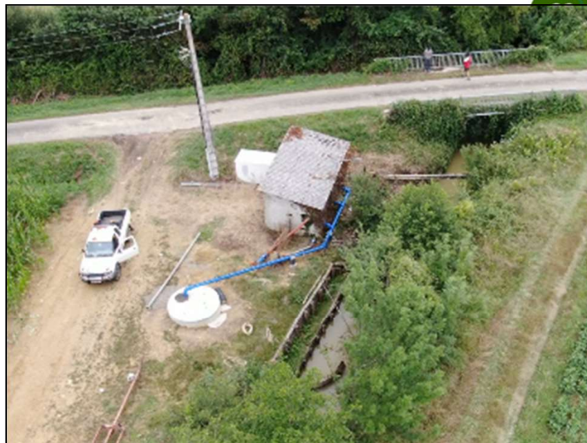
Suppression d'un seuil à Castelnavet / Lupiac création d'un puit d'un en berge
