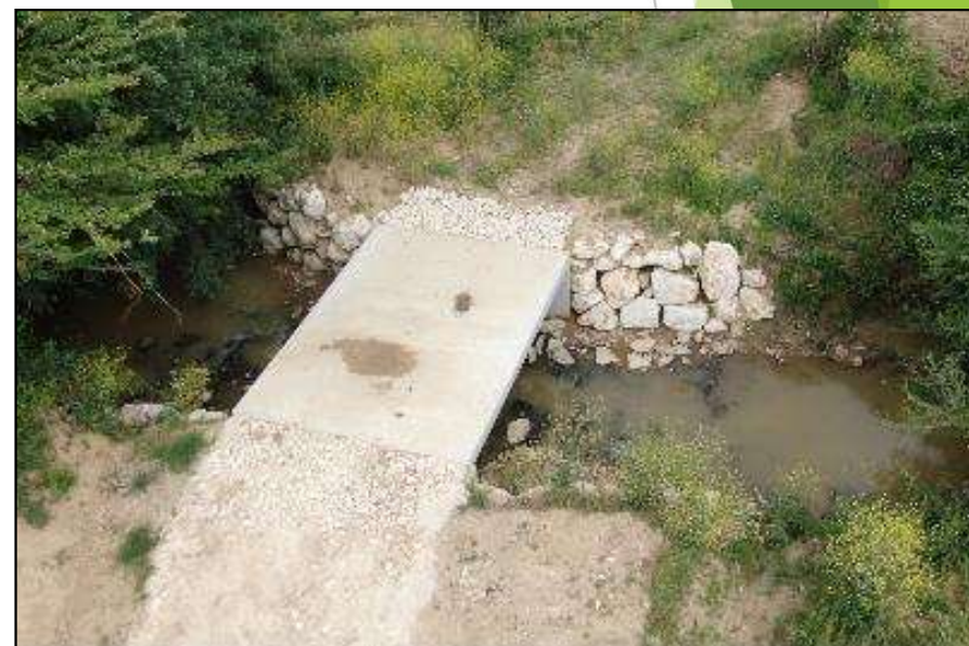
Suppression d'un seuil à Urgosse et création d'un passage
