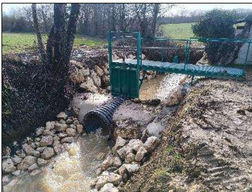
Suppression d'un seuil à Saint Pierre d'Aubézies par la création d'un vannage
