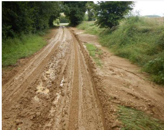
Coulée de boue sur route
